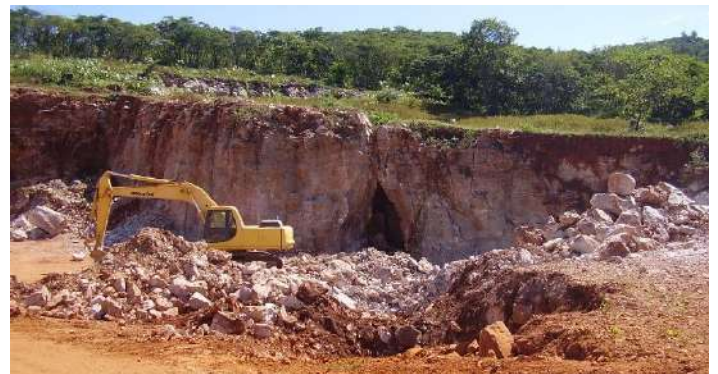
Figura 13 - Gruta localizada na parte leste da cava principal de extração mineral em Santa Maria da Vitória/BA (extraída do Laudo 529/09 – SETEC/SR/DPF/BA).
