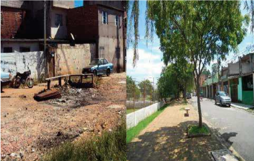
Figura 13 – Trecho do Parque Linear Itaim, com hierarquia de funções: habitação, rua como divisor do espaço público e do espaço privado, arborização, calçada larga, equipamento e o Córrego Itaim (não mostrado na foto). Foto: SVMA, 2012.
