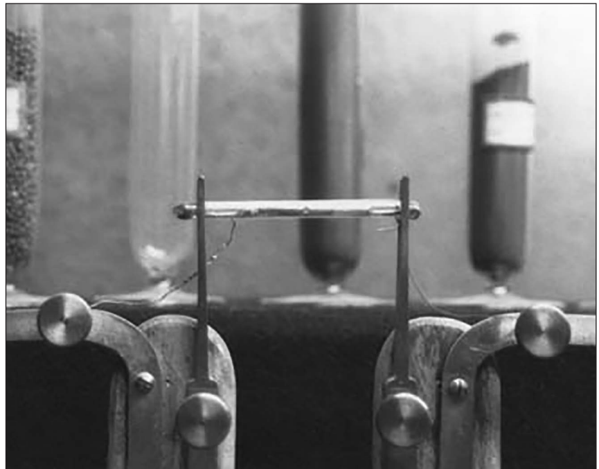
FIGURE 1 – One of Branly’s early radioconducteur , 1890. (Photo courtesy of Wikimedia Commons.)
