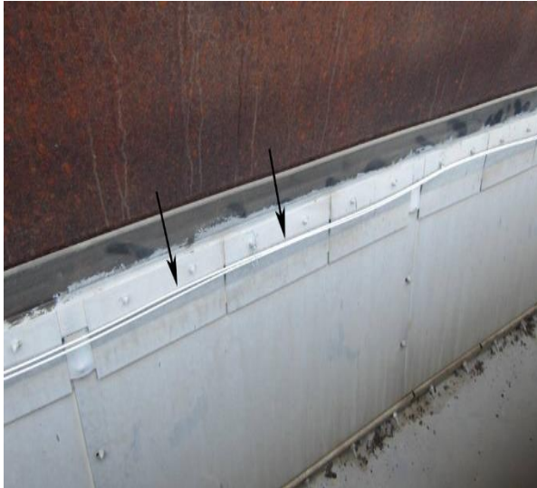
Fig. 57: Linear Heat Detector
