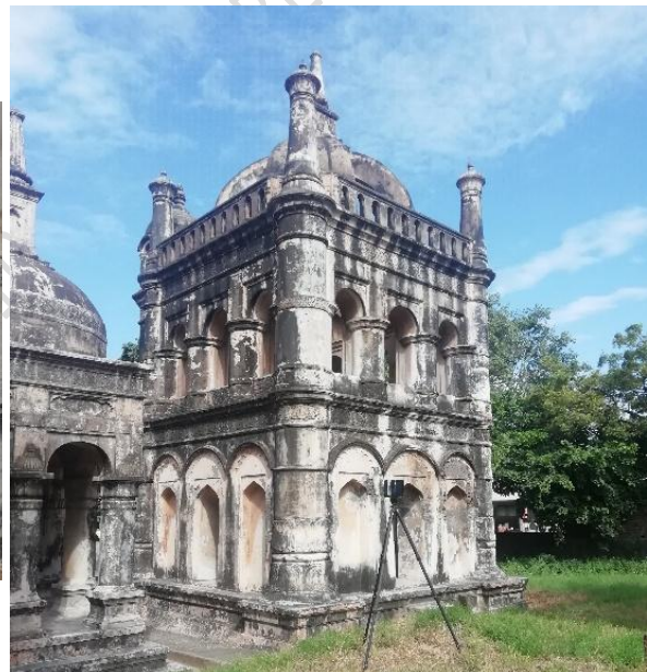
(d) Scanning work on site
