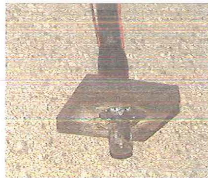
Figura 5.11 - Ilustração do chumbador e sua ancoragem.
