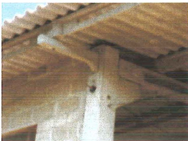
Figura 2.17 - Ligação viga-pilar - sistema passante.
