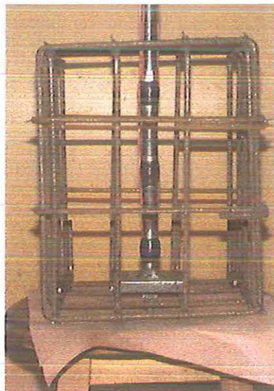
Figura 5.3 - Armadura do bloco e chumbador.
