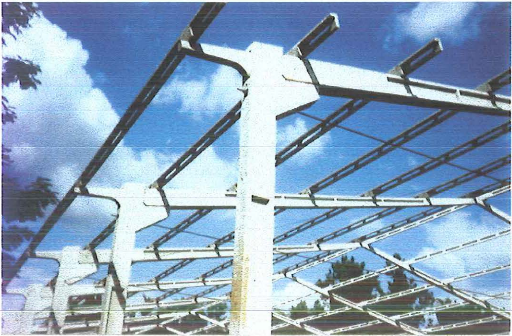
Figura 2.15 - Ilustração dos elementos estruturais dos galpões pré-moldados.
