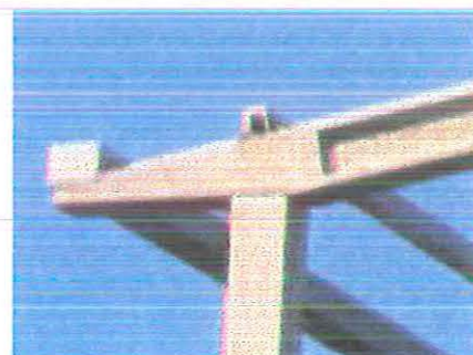
Figura 2.18 - Ligação viga-pilar executada sem a utilização de consolo.
