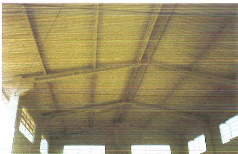
Figura 2.22 - Contraventamento longitudinal dos pórticos.
