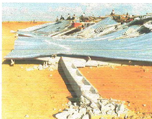
Figura 6.2 - Desabamento de um galpão pré-moldado.
