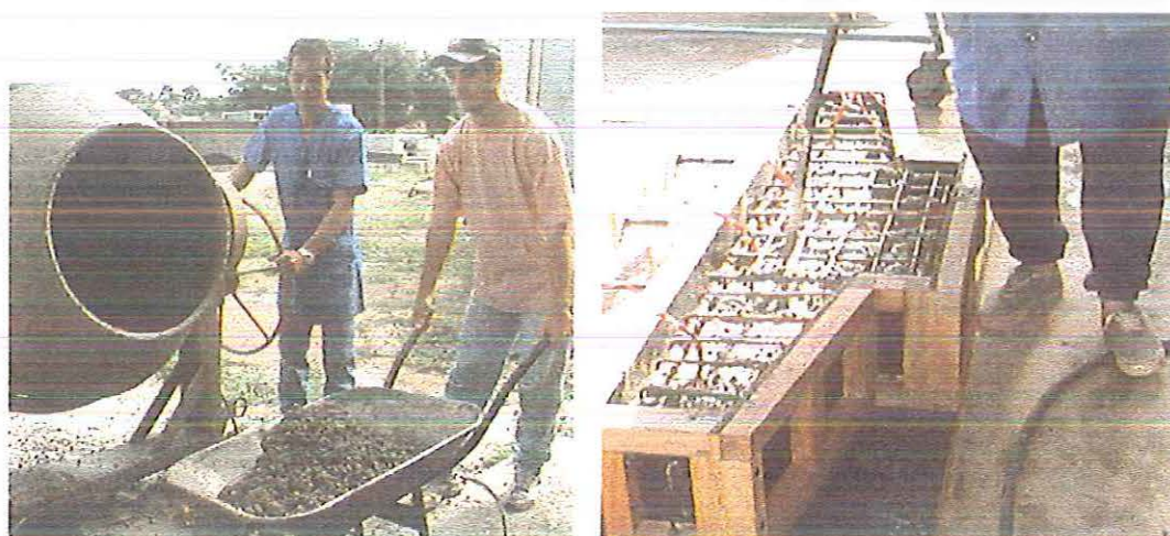
Figura 5.15 - Concretagem e adensamento do modelo.
