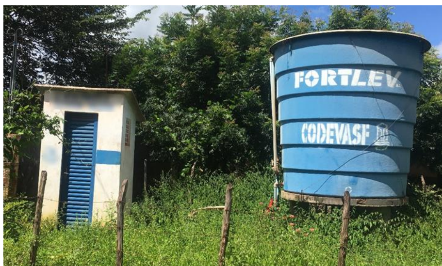
Figura 1. Chafariz do povoado Barra Nova, Cocal de Telha (PI) com o centro de operação da bomba d'água a esquerda e o reservatório de água a direita, e centralizado entre ambos, o poço tubular. Fonte: Brito et al. (2019).
