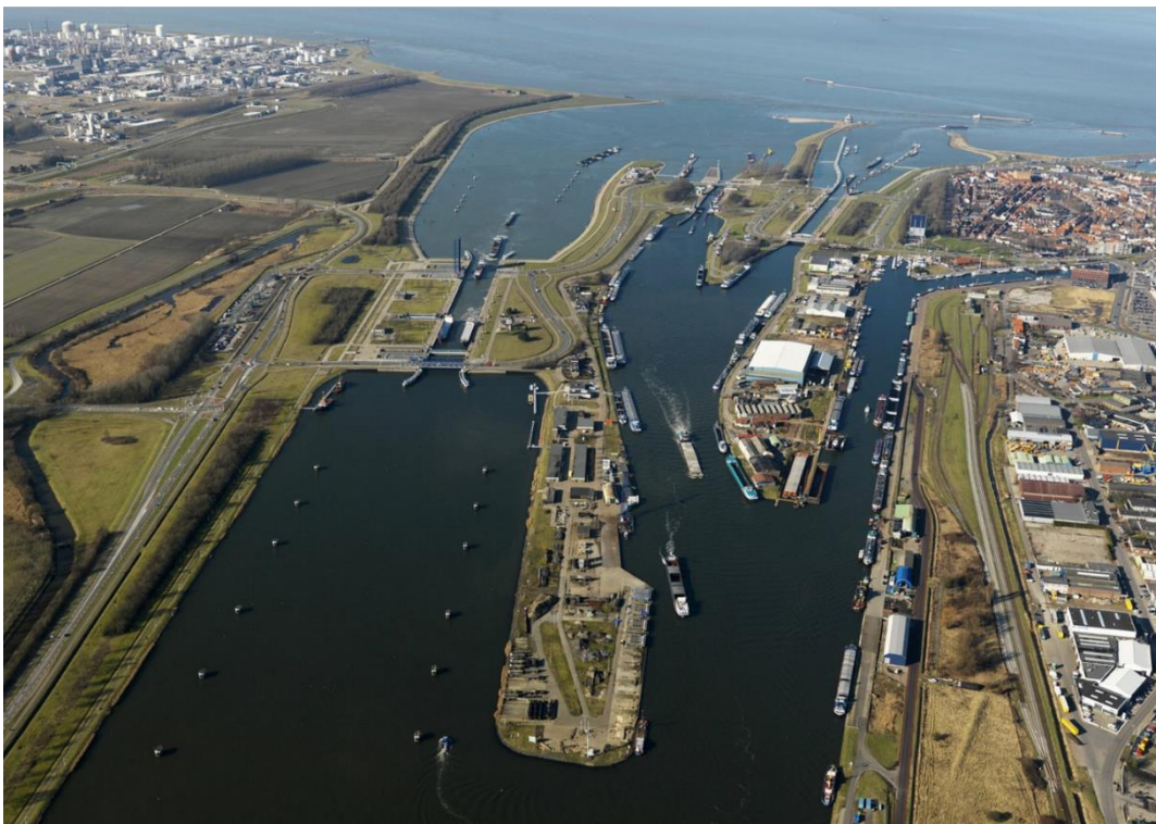
Figure 26. Lockcomplex Terneuzen (Portaal van Vlaanderen, 2016)
