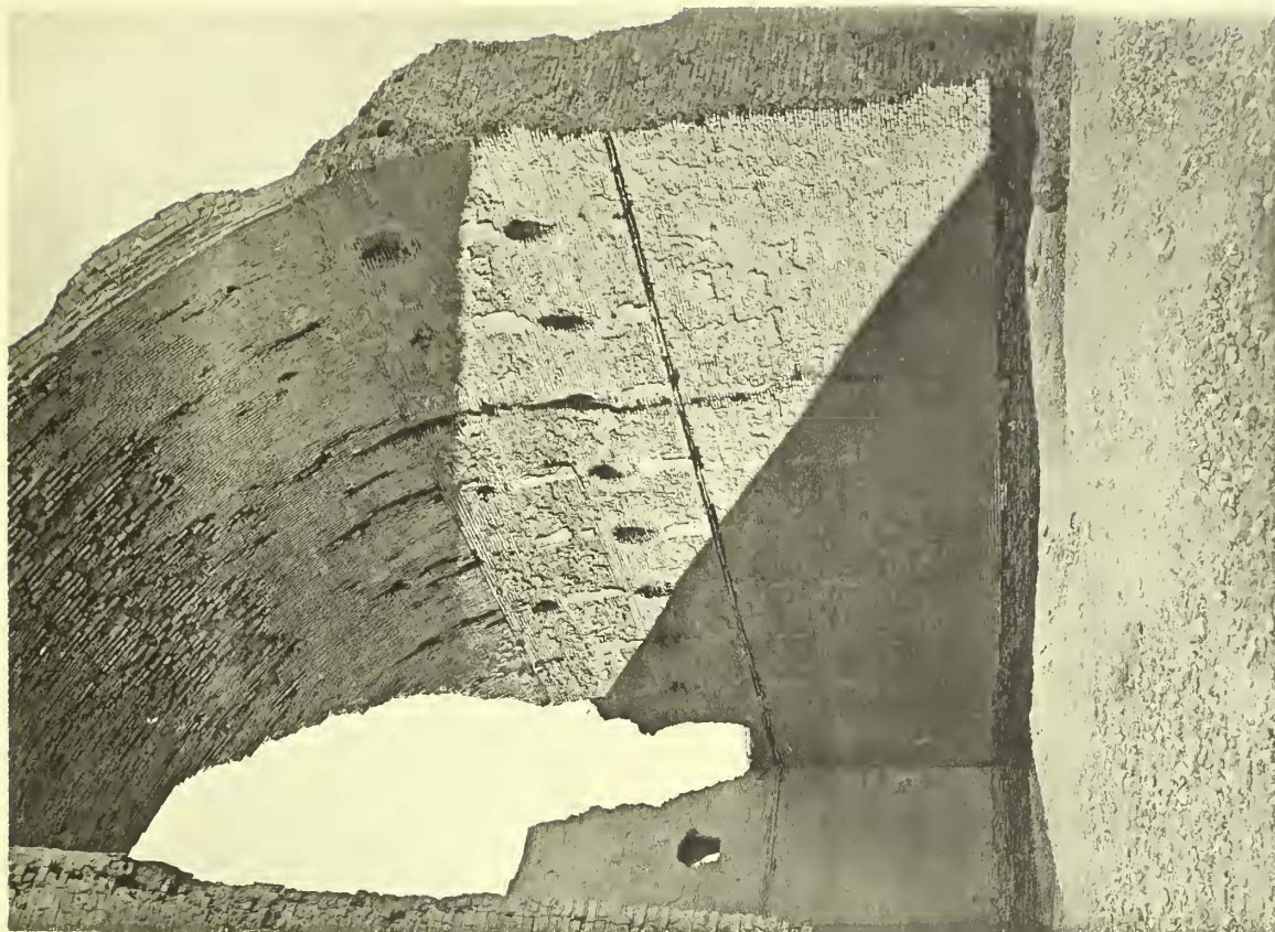
KTESIPHON, Tāq i Kisrā, Gewölbe
