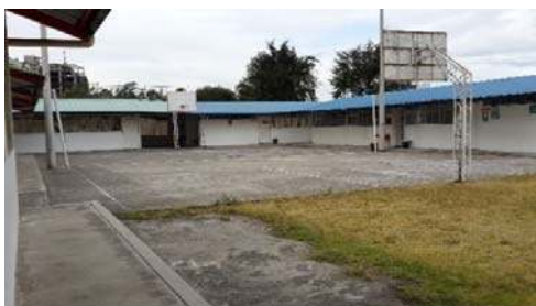
Figura 2 Instalaciones del CIBV Manuela Cañizares
