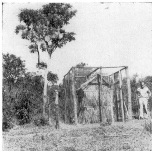
Fig. 7 — Galinheiro experimental construído na área C1 do Bairro João Pedro.
