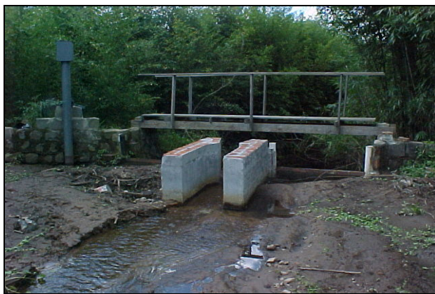
Figura 2 - Calha de fundo plano, instalada na estação fluviométrica do Arroio Vacacaí-Mirim em Sítio do Tio Pedro, Santa Maria/RS.
