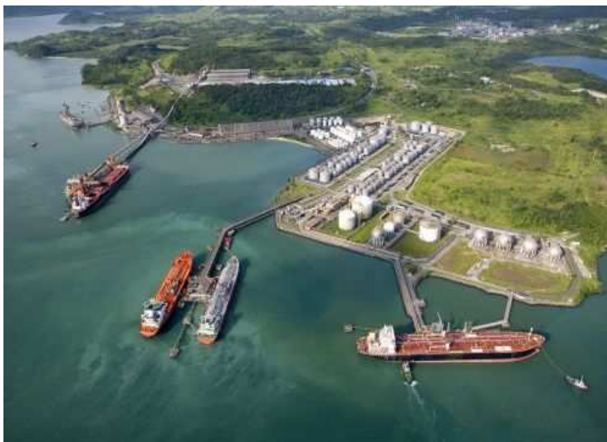
FIGURA 2 – Vista aérea do Porto de Aratu, Baía de Todos os Santos, Bahia. Fonte: Agência Nacional de Transportes Aquaviários - ANTAQ
