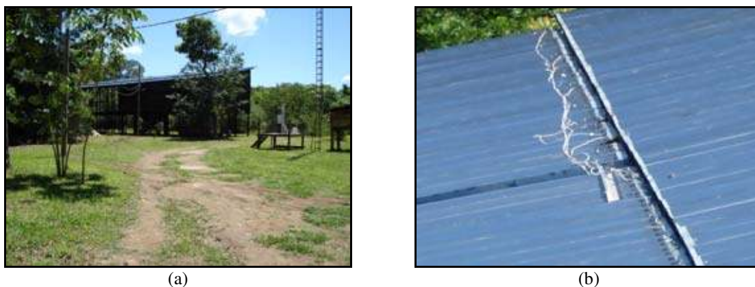
Figura 4.28 Galpão do SHGD: (a) vista frontal, com a torre da estação meteorológica à direita; (b) vista superior do telhado, mostrando detalhes das conexões elétricas entre as strings.
