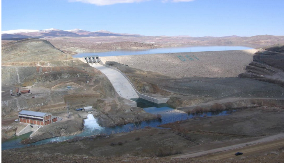
Şekil 1: Bahçelik Barajı ve HES Genel Görünümü [15]
