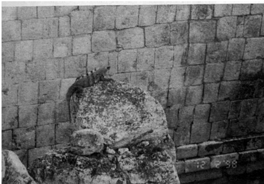
Figura 1: Uxmal, pared contigua a la Pirámide del Adivino donde se observan las costras de color oscuro.
