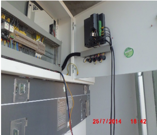
Şekil 3. Şebeke analizörünün OG tarafına bağlantı şekli
