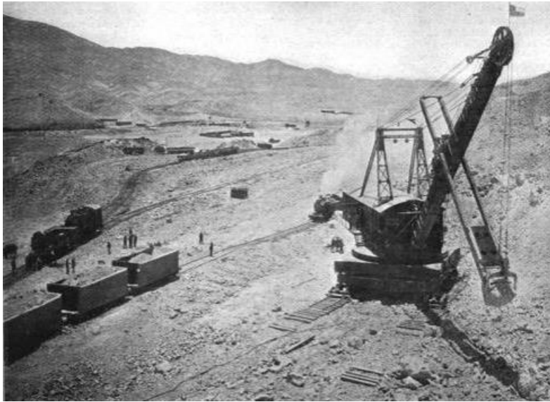
Figura 5. La mina de Chuquicamata en su etapa industrial open pit en 1920. Se aprecia la famosa pala, la misma maquinaria que participó en la construcción del Canal de Panamá. Fuente: Revista Ingeniería Internacional. 1922. “El mineral de Chuquicamata”, Tomo 7, Nº 5, Nueva York.
