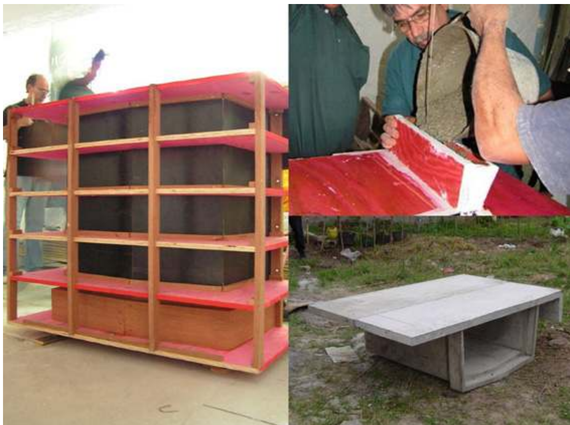
Figura 5: Execução do protótipo da calçada drenante em um centro comunitário na periferia de Montevideu, Uruguai, em 2006.
