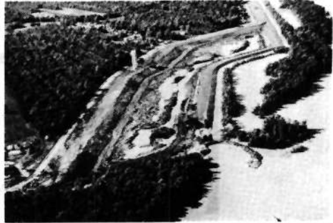
Fig. 53. Montz: set-back levee
