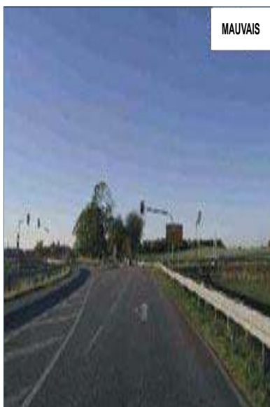
Figure 5 : Jonction, perceptible seulement 100 m avant : freinage inattendu et vitesse trop élevée à ce point causent des accidents [16]
