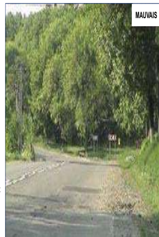
Figure 8 : Le tracé du virage n'est pas perceptible car la courbe intérieure est cachée : freinage inattendu, coups de volant et vitesse trop élevée causent des accidents [23]
