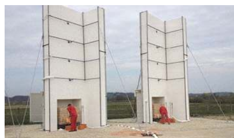
Slika 9. Paljenje konstrukcije od drvenih letvica – početak požara
