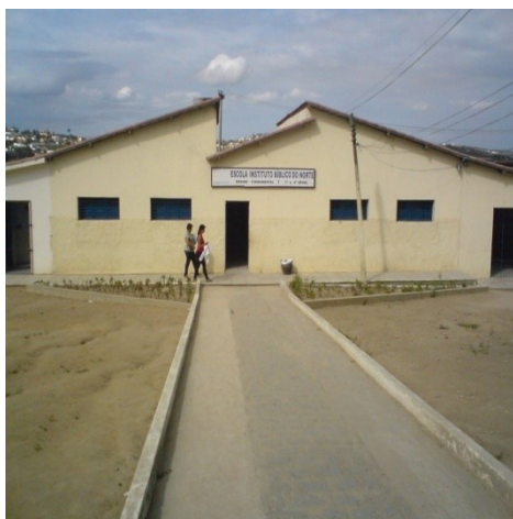
Figura 2. Fachada principal da Escola
