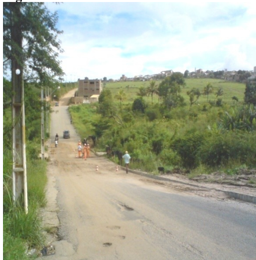
Figura 9. Via lateral de acesso à Escola
