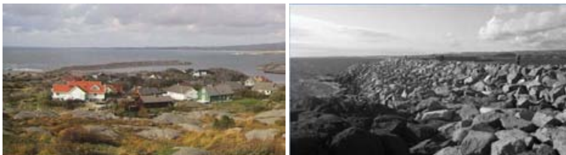
Figure 3. La digue à berme de Sirevag en Norvège.
