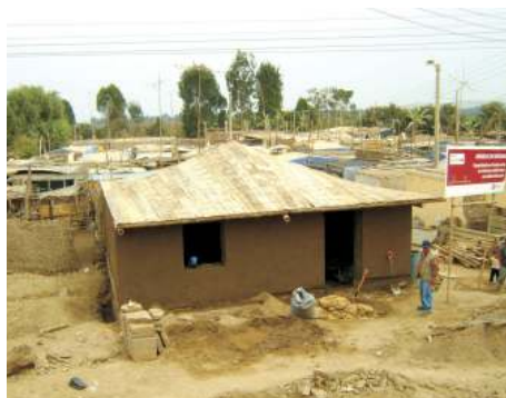
31. Pobladores construyendo sus propias casas en Chincha, Ica
