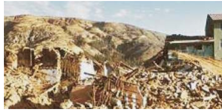
5. Casas de adobe destruidas por los sismos de Huaraz, 1970 (Fuente: NISEE) y de Pisco, 2007
