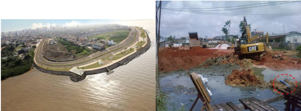
Figura 3. à esquerda retrata a “conclusão” da primeira fase do PROMABEN, a qual esta dividida em três fases, sendo denominada “Portal da Amazônia”. Fonte: play47.blogspot.com e Figura 4. à direita aterramento e dragagem do canal Bernardo Sayão, com sucção das águas (círculo vermelho) para melhor aterrar e consolidar a área. Fonte: autor (novembro/2012).
