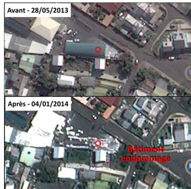
Figure 6 : Exemple de dégâts aux bâtiments, effondrement d'un immeuble, suite au passage du cyclone Bejisa, la Réunion, janvier 2014. Comparaison situation avant crise et post crise (Pléiades)
