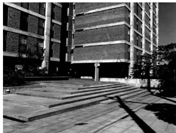
Figura 3. Conjunto de Edificios Gemini, Calle Graúna 419, barrio Indianópolis, São Paulo, 1970 Fuente: Wakahara (1970).
