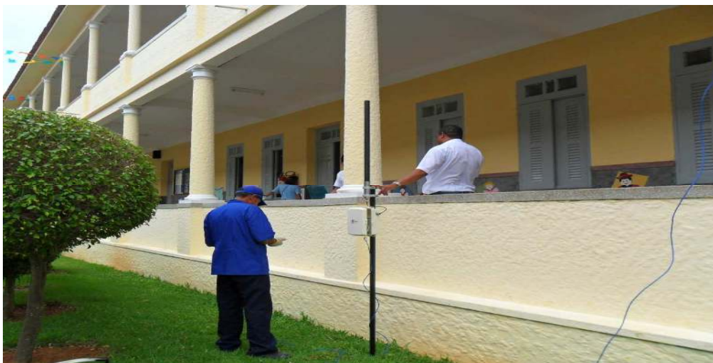
Figura 06 – Átrio do Bloco Central do CNSN
