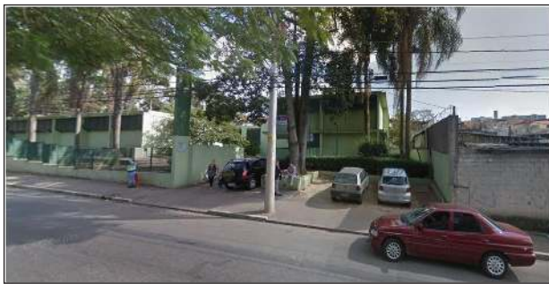
Figura 7 - UBS Dom João Nery, Estrada Dom João Nery, 3462 Fonte: Google Street View (2017).
