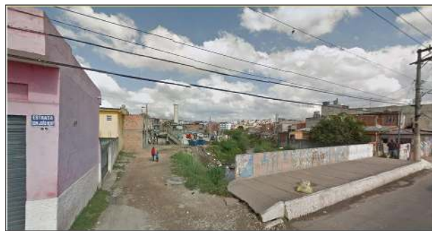
Figura 11 - Marginal do Córrego do Lajeado no cruzamento com a Estrada Dom João Nery. Observa-se o desmoronamento da margem Fonte: Google Street View (2017).
