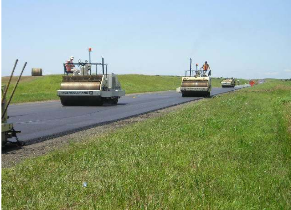
Fig. 27. Compaction
