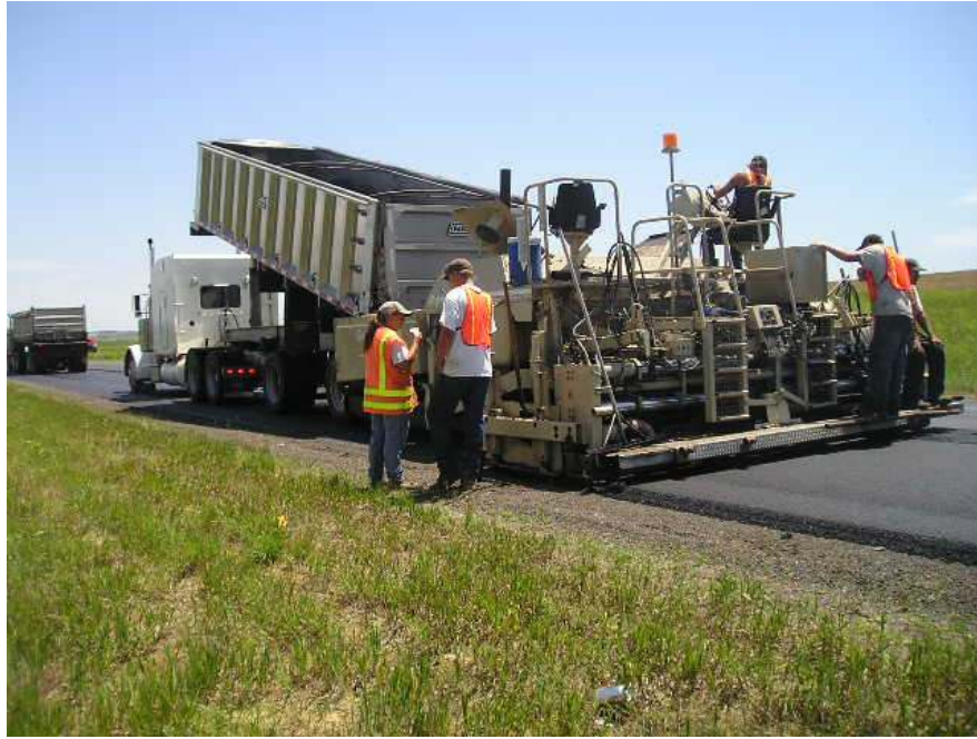
Fig. 25. HMA paving
