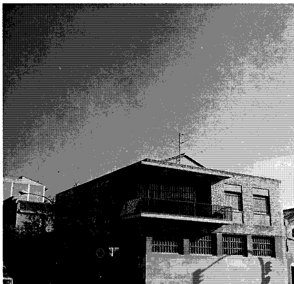
FIGURA 6.—Ejemplo de control solar mal dimensionado. La foto ha sido realizada en diciembre a las 13,00 horas. La orientación de la superficie acristalada es NO. La vivienda está ubicada en Sabadell.
