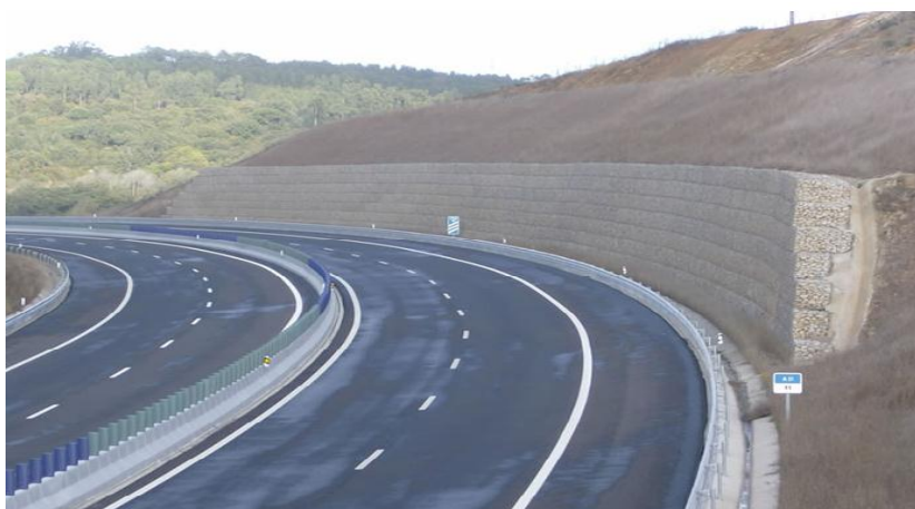
Fig. 3.1 – Muro de Gabiões (www.smp.pt)
