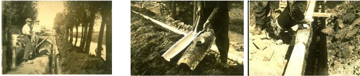
Fig 8-1 Het aanleggen van een gietijzeren leiding en een loodstriktouw verbinding voor 1940
