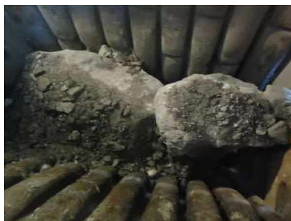
Figura 12: Entupimento por matacões
