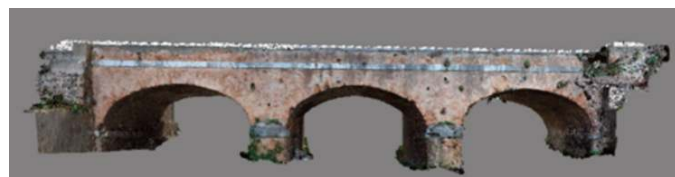
Fig. 4 - Texture del ponte di Villa San Giovanni rilievo da drone (fonte: propria elaborazione)
