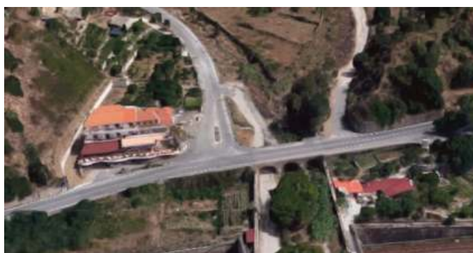
Fig. 1b - Inquadramento del ponte sito in Villa San Giovanni (fonte: propria elaborazione)
