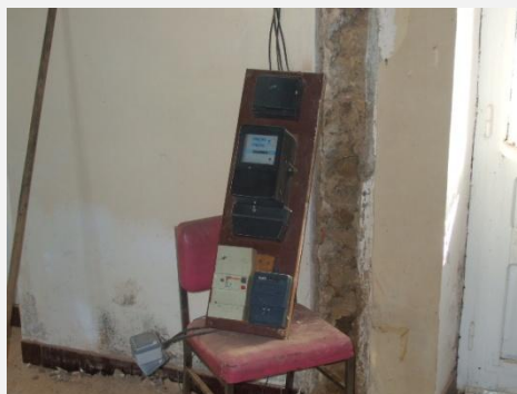
Figure 23 : Photo prise et remontée par le technicien.
