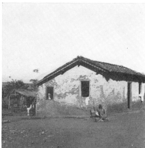
Fig. 10 — Casa do Bairro João Pedro, mostrando a construção de tijolos não revestidos.
