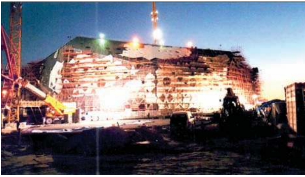
Рис. 9. Строительство культурного центра (вид в вечернее время)
