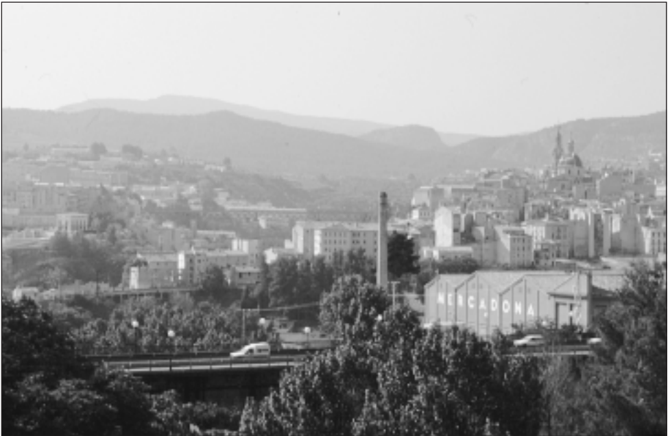
FOTO 3. Alcoy, rehabilitación de la fábrica textil de Terol en supermercado. Obsérvese el respeto de la fachada y de la chimenea.
