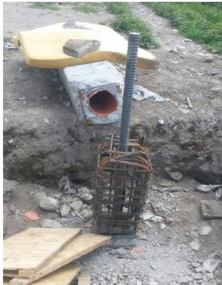
Fig. 65 – Reforço em gaiola, barra Dywidag e placa de fixação na secção inferior
