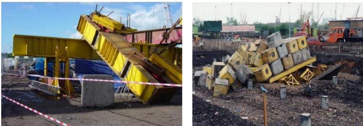
Fig. 14 – Exemplo de acidentes durante a execução de ensaios de carga estáticos. Fonte: Adaptado de (Handley, B. et al., 2006)
