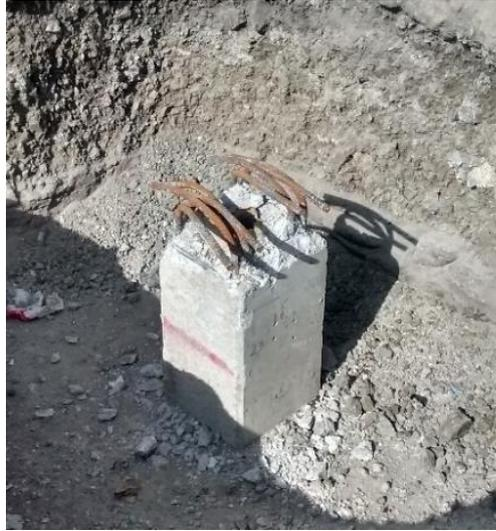
Fig. 64 – Demolição do topo da estaca
