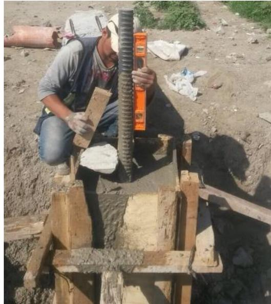
Fig. 66 - Coffragem da cabeça da estaca e acabamentos finais
