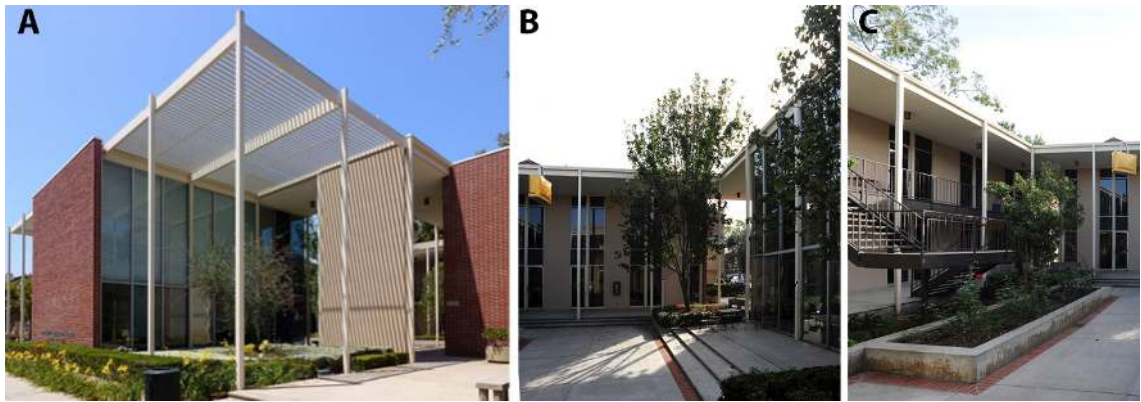
Figura 1. Fachada principal [A] e pátio interno [B,C] do URC. Fonte: Arquivo pessoal.
