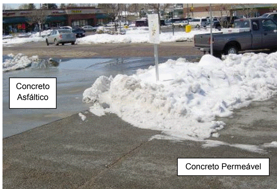
Figura 1.17: Diferença entre superfícies de pavimento de concreto permeável e pavimento asfáltico impermeável após a ocorrência da precipitação (Fonte: www.perviouspavement.org )
