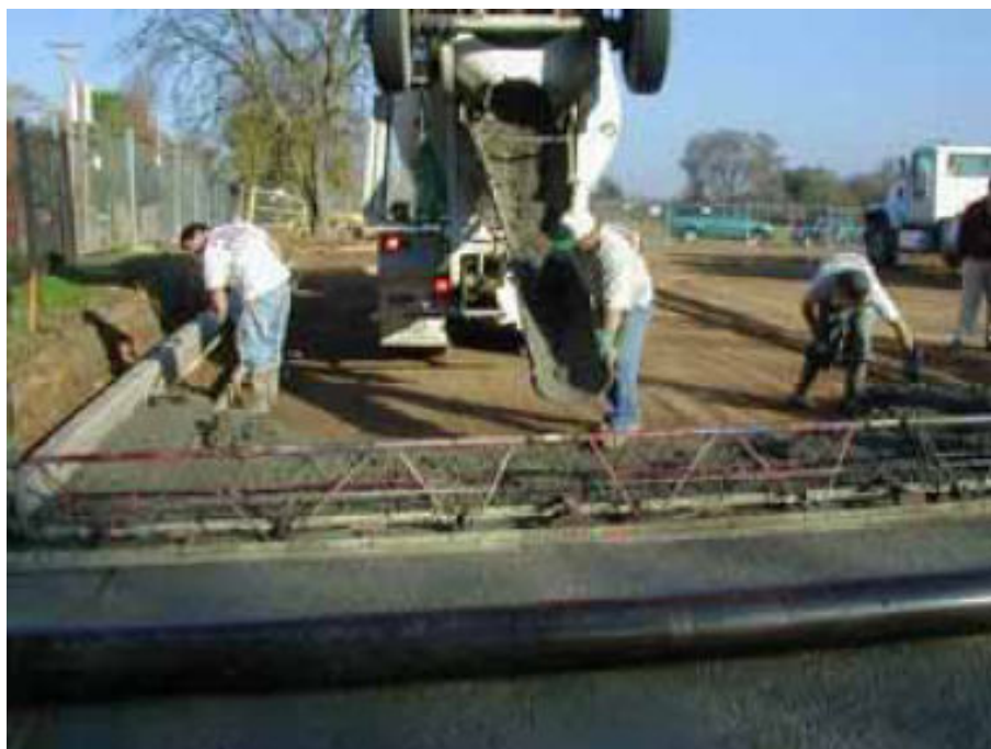
Figura 1.19: Procedimento de lançamento do concreto permeável (Fonte: YOUNGS, 2005.)
