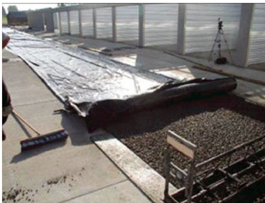
Figura 1.23: Lona plástica utilizada para proteção do concreto permeável contra a perda precoce de água (Fonte: www.perviouspavement.org , 2011.)
