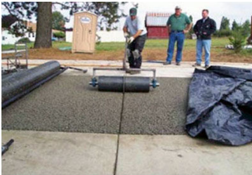
Figura 1.22: Rolo utilizado para fazer as juntas no concreto permeável (Fonte: www.perviouspavement.org )
