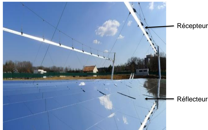
Figure 9-3 exemple de champ solaire thermodynamique à miroir de Fresnel (source: http://www.astf-alcen.com/fr/applications/energie )
