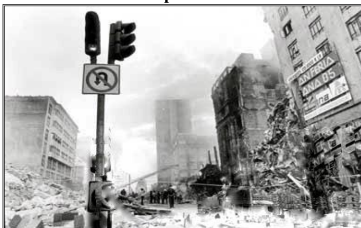
Fotografía 5. Avenida Juárez después del sismo de septiembre de 1985.
