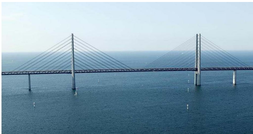
Figura 3.2: Vão principal da Ponte Oresund
