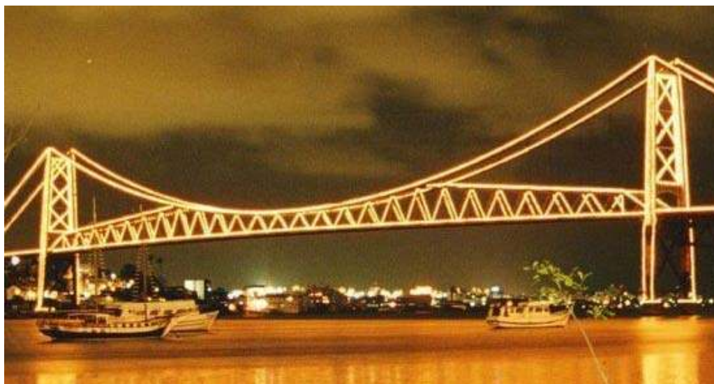
Figura 3.6: Ponte Hercílio Luz
