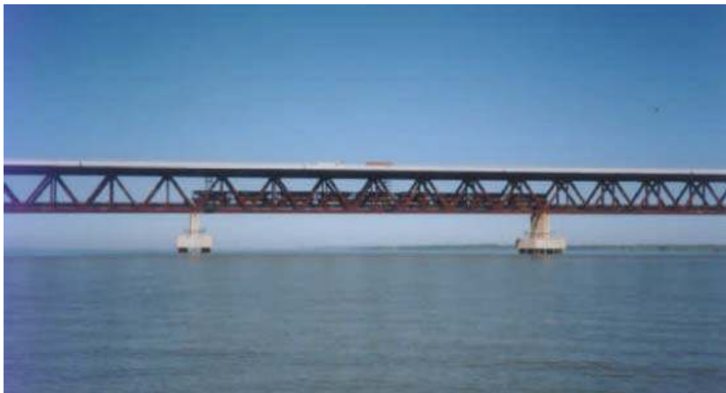
Figura 3.7: Ponte Rodoferrôviária sobre o Rio Paraná
