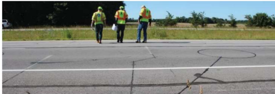
(d) WIM station #952100 pavement and sensor conditions
