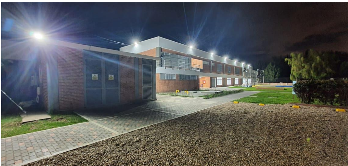
Fuente. Propia. registro fotográfico entrega final proyecto B.
