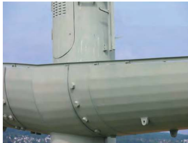
figure 20 Vue de l'intersection fût-bras.
