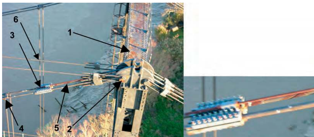
figure 11 Vue de la tête de pylône Zoom sur le repère 5.
