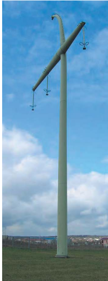
figure 13 Pylône de type Fougère Conception : I. Ritchie (architecte), K. Gustafon (BE) RFR.
