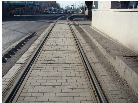
Fig. 14. «Large slab» superstructure
